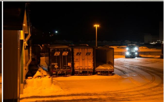
Photos avant et après sur le site d'une compagnie de transport à Lac-Mégantic. Les projecteurs DEL blanc-froid ont été remplacés par des appareils PC-ambre entièrement défilés.
