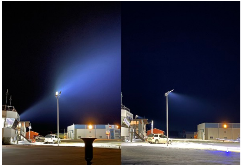
L'éclairage mal orienté de l'aéroport envoyait la majeure partie de la lumière vers le ciel. La ré-orientation des luminaires a permis de limiter la lumière gaspillée et de mieux éclairer le tarmac.
